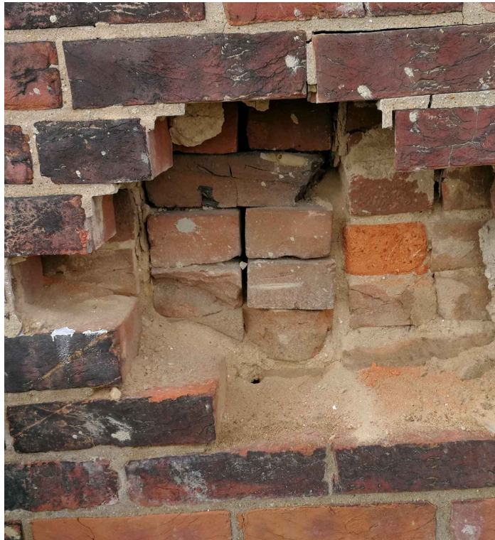
1 A13 EXPLORATORY BRICK DEMO SCALE: NA
