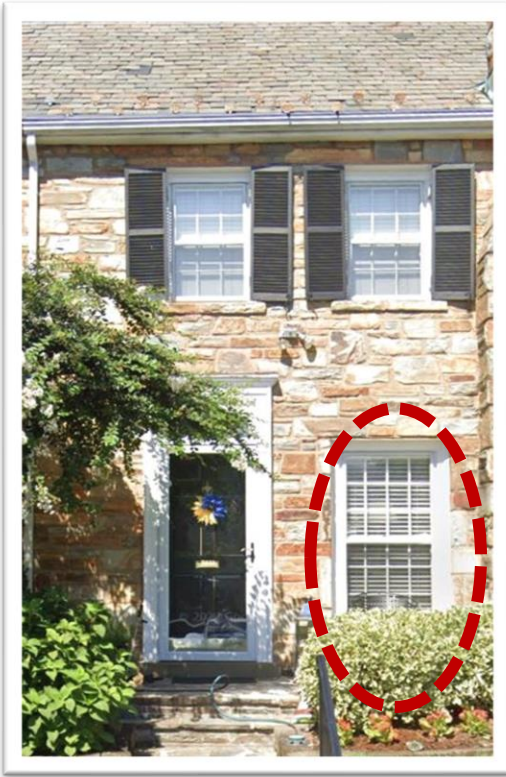
927 S. ST. ASAPH ST. OPERABLE WINDOW
