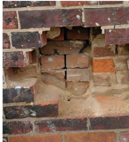
1 A13 EXPLORATORY BRICK DEMO SCALE: NA
