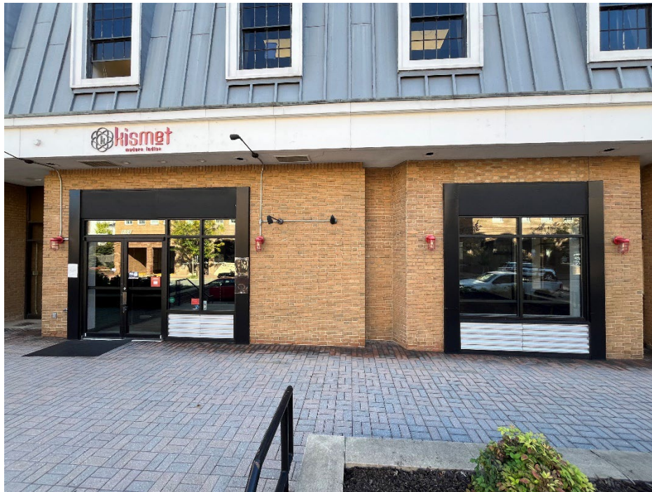
Figure 1: 111 N. Pitt existing
