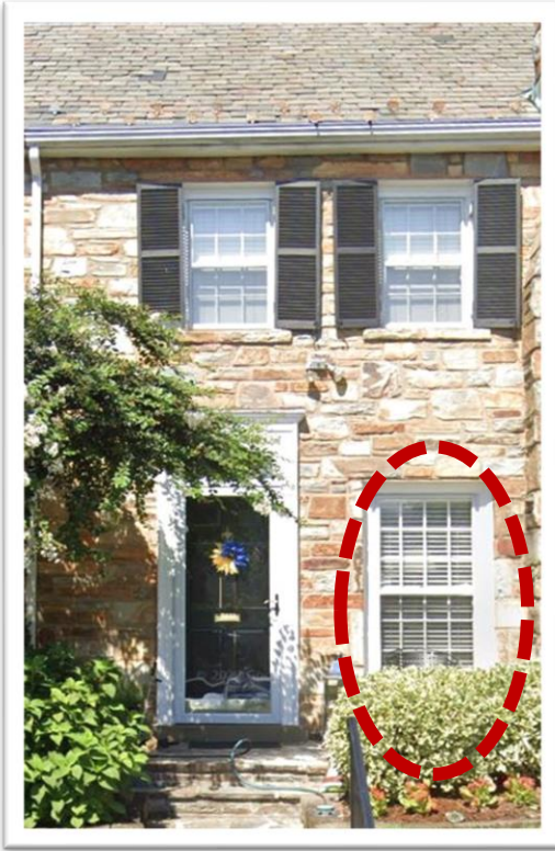
927 S. ST. ASAPH ST. OPERABLE WINDOW
