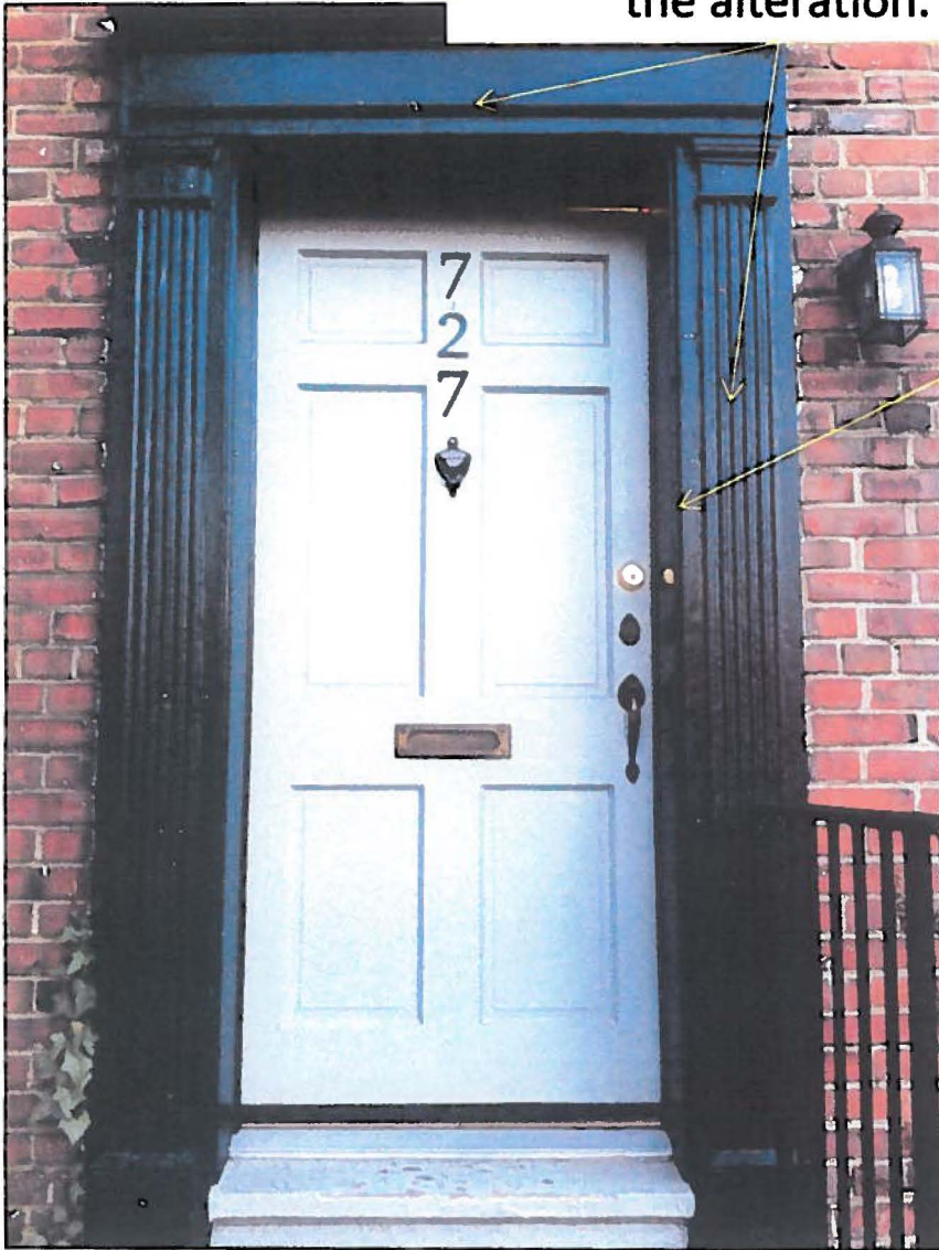
Existing wood door
