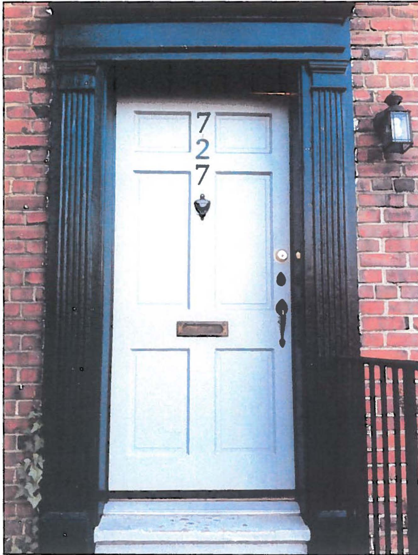
Existing wood door
