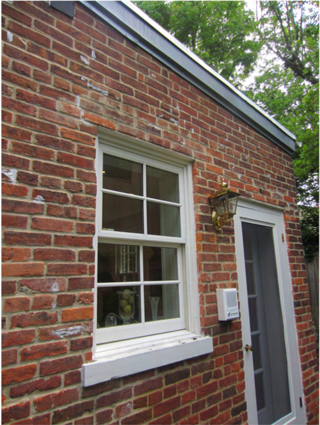
1. South Wall of 1-Sotry Ell
